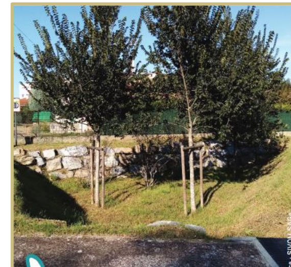
Portet-sur-Garonne (31) – Gestion intégrée des eaux pluviales
