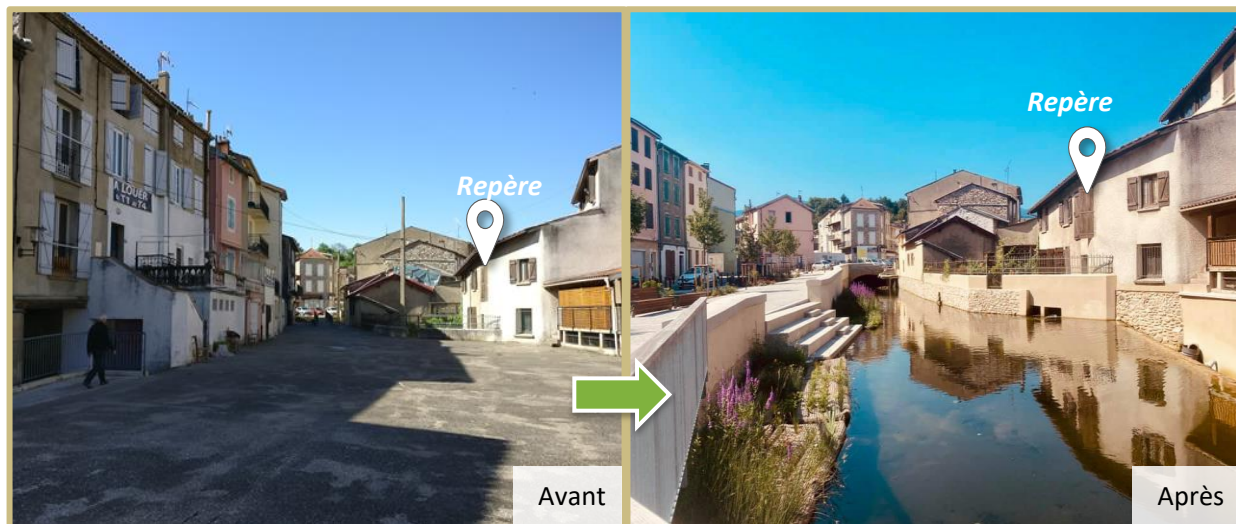
Lavelanet (09) – Remise à jour d'un cours d'eau en centre urbain
